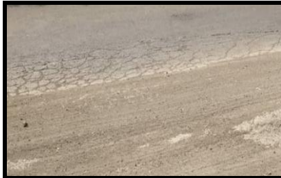
Fig 3 : Fatigue cracking
