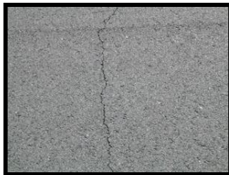
Fig 4 : Longitudinal cracking
