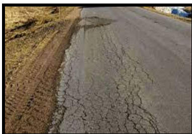
Fig 4 : Edge Cracking
