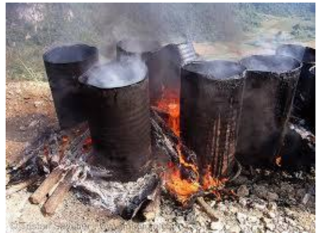
Fig-3 Burning Bitumen
