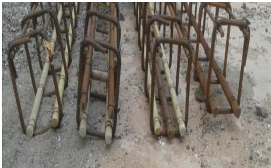
Fig - 5 : Reinforcement cage
