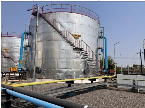
4. Main digester (overhead) Predigester– 2 nos.
